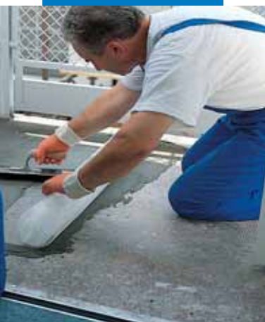
Гидроизоляция балкона с помощью Mapelastic, армированного сеткой из стекловолокна
